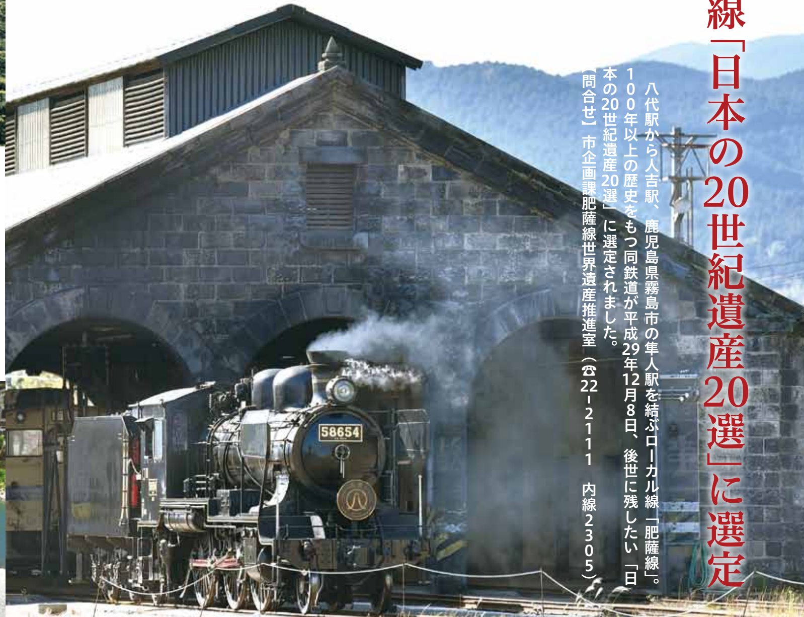
▲全国で唯一現役で活躍する石造りの車庫。人吉機関車庫は、球磨地方特有の溶結凝灰岩で造られている
