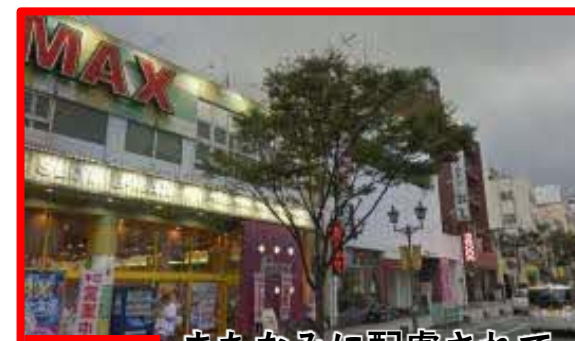
3-11 まちなみに配慮されていない看板の例
