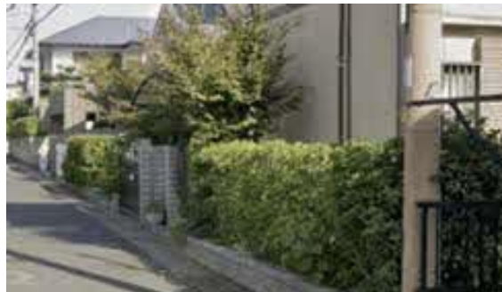
2-14 敷地内に電柱を設置
