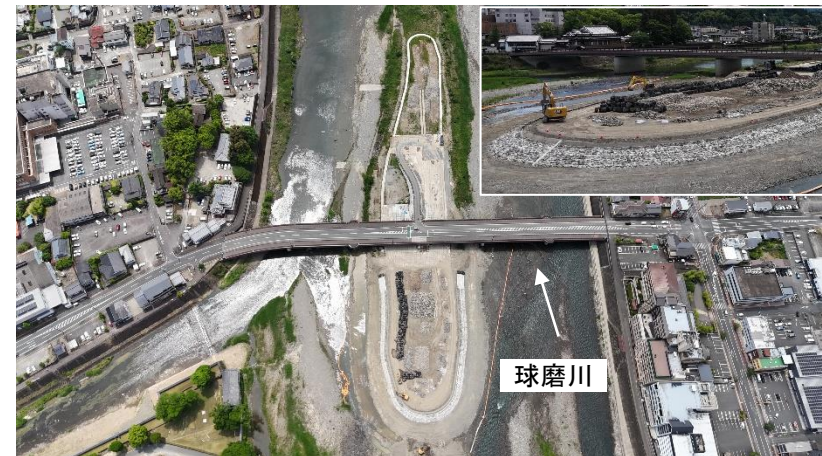
R8.5末 護岸工事の状況
