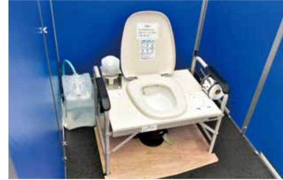
下水道管路にあるマンホールの上に簡易トイレ設備を設け、災害時に使用します。令和2年度は人吉東小に整備予定です。
