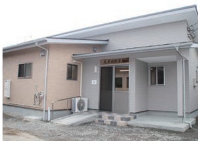
▲完成した北泉田町会館
