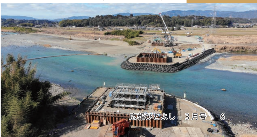
▼復旧作業中の球磨川第四橋梁(肥後西村～川村間)
