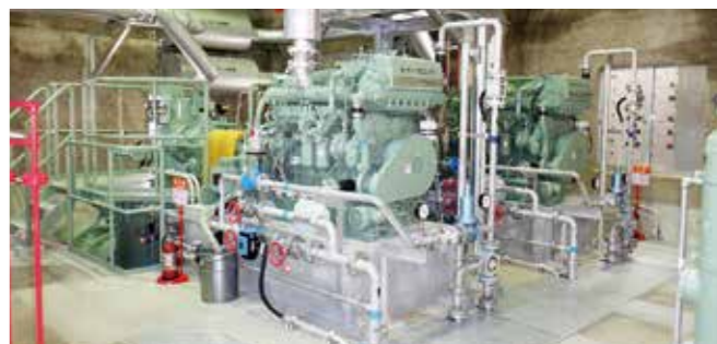
災害復旧を進める下水道施設
