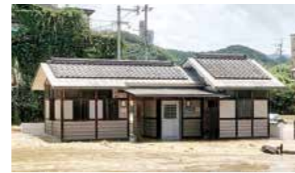
青井ハス池ポケットパークの被災状況
