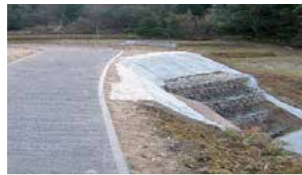
復旧完了(令和4年2月)
