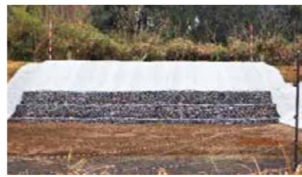
復旧完了(令和4年2月)
