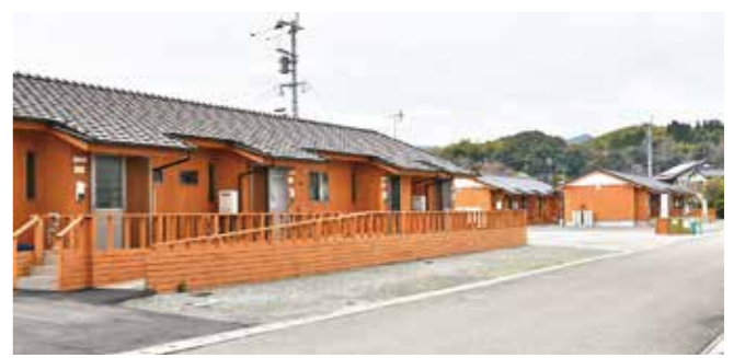
入居期間が1年延長となった応急住宅
