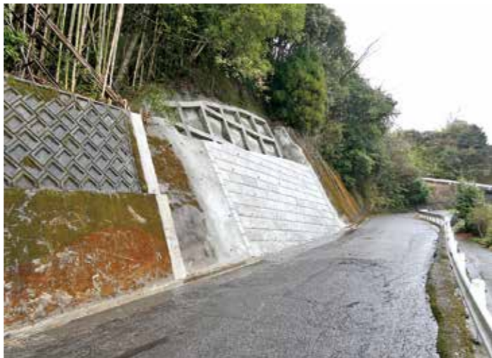
復旧工事が完了した東漆田石野線
