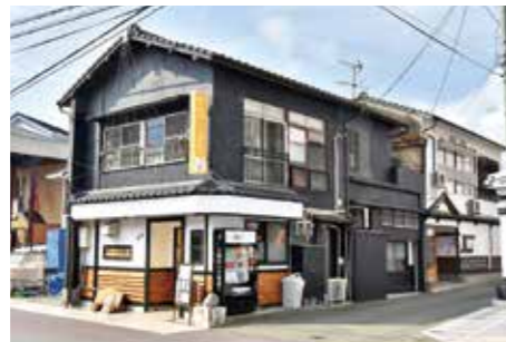
▲1階が食堂、2階は今後防災拠点に改修予定
