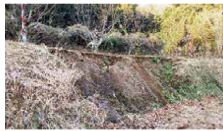
農地（東漆田地区）の被災状況
