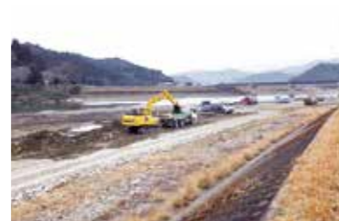
堆積土砂撤去中（大柿地区）
