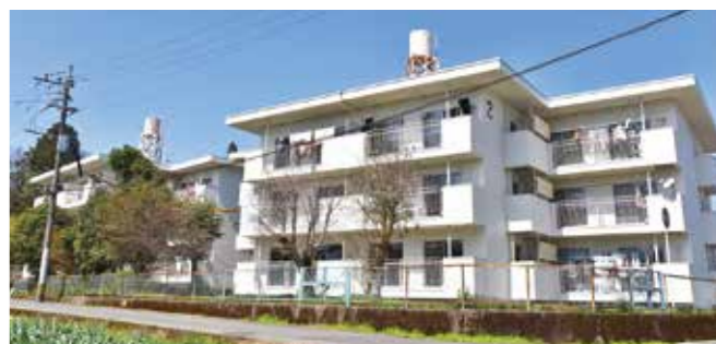
令和4年度に原城団地の給水設備を改修
