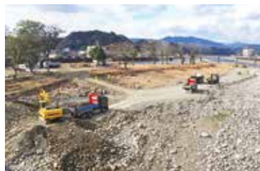
堆積土砂撤去中（中川原公園周辺）
