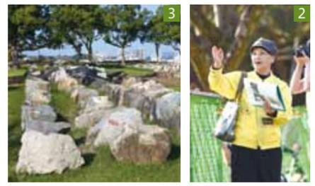
1\_複数箇所石垣が損壊(写真は戌亥櫓) 2\_修復中の熊本城を案内するボランティアガイド 3\_同じ位置に復元するため整理された崩れた石垣
