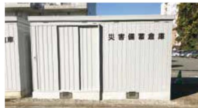
災害備蓄倉庫
