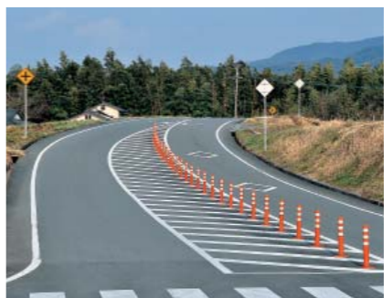
整備が進む県営錦南部農道
