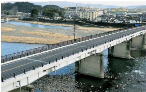
補強工事が終わった人吉橋
