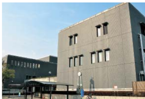
老朽化が進むカルチャーパレス
