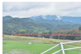
天狗橋（中神町）の被災状況
