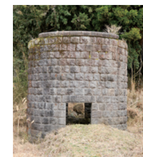
駅舎東側にある給水塔
