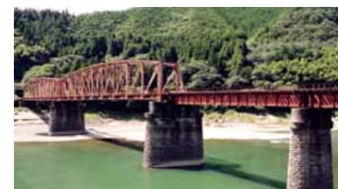
▲左(人吉側)がトラス構造、右(八代側)がプレートガーダー構造
