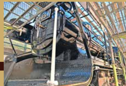
足場を組んで塗装
