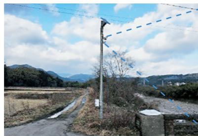
令和2年7月豪雨以降の河川カメラの設置場所（万江川）
