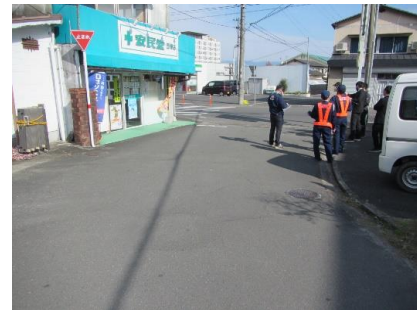
⑩ 市道青井西間線 【対策前】
