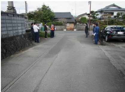
⑨ 市道西間地内第7号線 【対策前】
