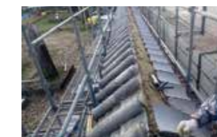
復旧中の復元建造物
