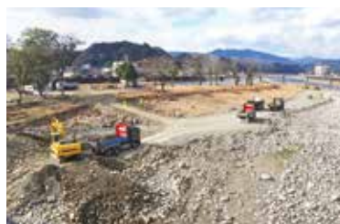
堆積土砂撤去中（中川原公園周辺）
