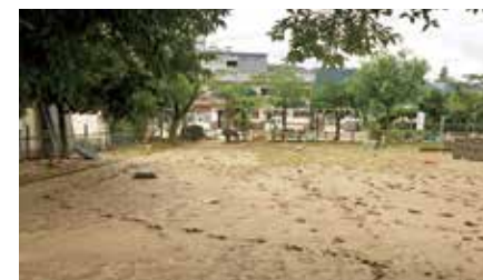
宝来町公園の被災状況
