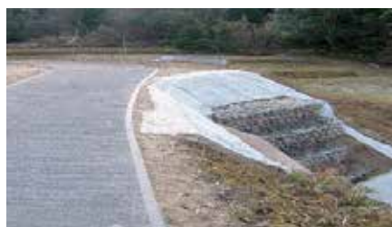
復旧完了(令和4年2月)
