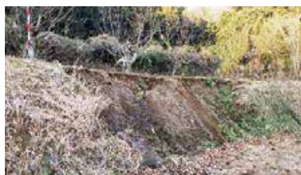
農地（東漆田地区）の被災状況
