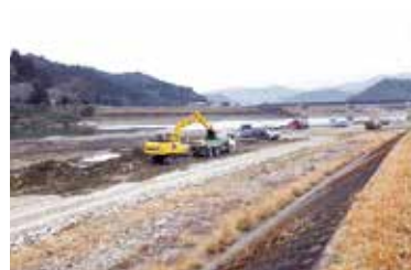
堆積土砂撤去中（大柿地区）
