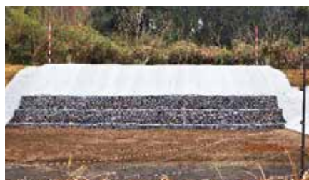
復旧完了(令和4年2月)
