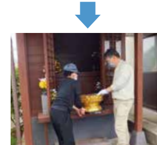
お堂復旧完了、釈迦像復旧中
