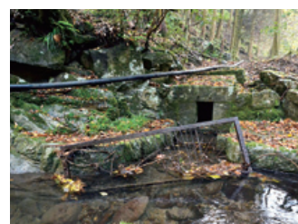
山深く入り込んだ場所にある大川間川の取水口。約4キロ先にある大畑駅へ水を送る。
