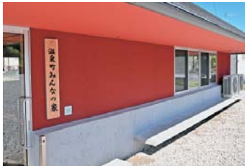
住民がくつろげるベンチを設置
