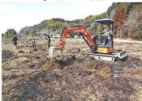
④重機による伐根
