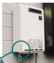
※水道管の凍結で給湯器の流入弁や減圧弁の破損が発生しています。
