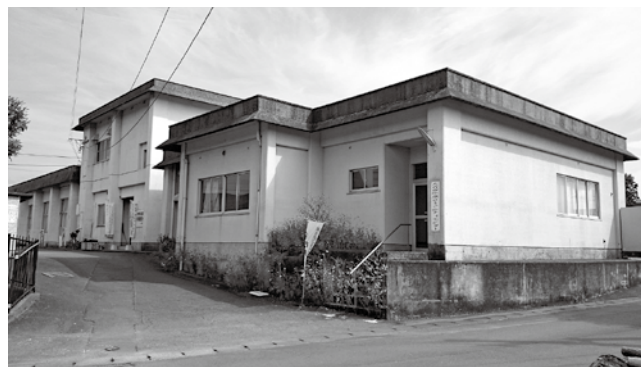
改修工事が予定されている中原コミュニティセンター
