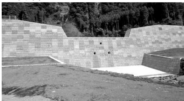
九州北部豪雨で被災した阿蘇市坂梨地区に建設された砂防ダム
