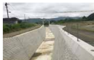
▲御溝川二次放水路の整備状況
