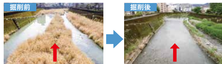
▲山田川の掘削状況
