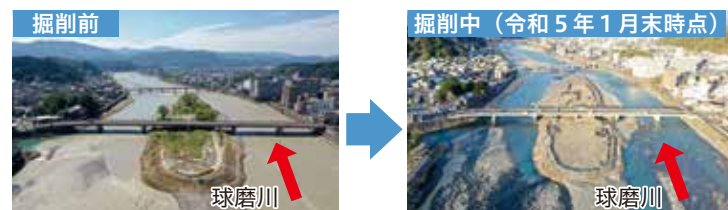
▲中川原公園の掘削状況
