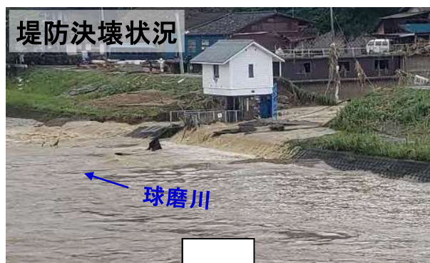
①堤防決壊箇所(球磨川右岸56.4k付近)
