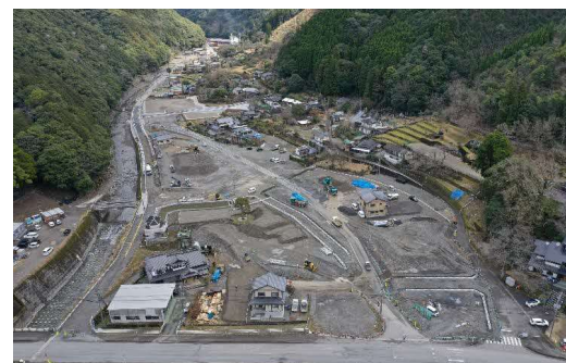
球磨村神瀬地区工事状況（R6.3.18） 【球磨村神瀬地区】
