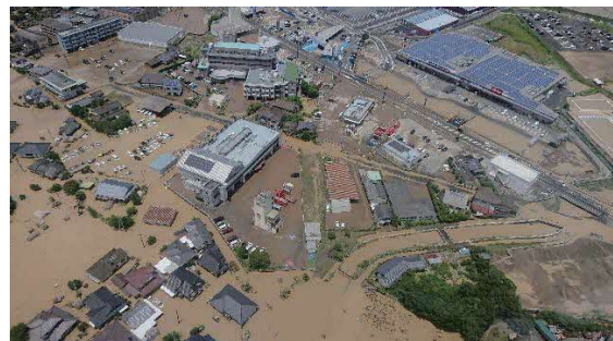
写真-3.5.31 消防本部周辺 2)
