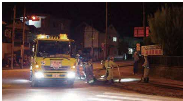
写真-3.6.4 路面清掃(人吉市) 10) (7月9日)
