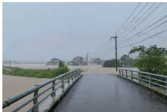
写真-3.5.10 現着時の浸水状況 2)
