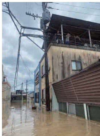
写真-3.5.4 現場付近(⑤位置) 2)
