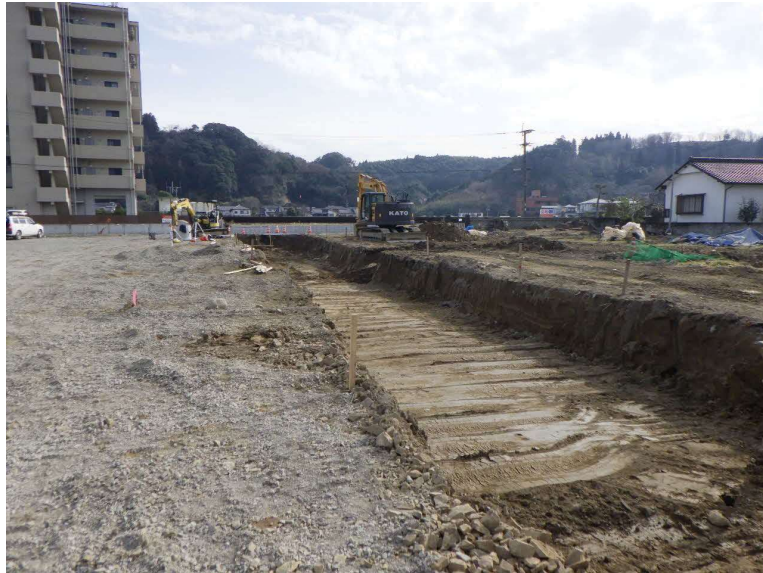
区6－11号線道路築造 （10街区と11街区の間）
