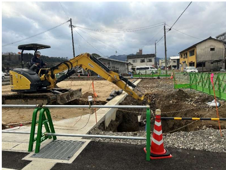
国道445号下水道管敷設
