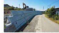
熊本地震 難問を解消する生活道路整備 緊急搬送や避難経路の確保
