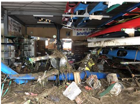
球磨川トレーニングセンター (令和2年7月豪雨災害で浸水被害)
