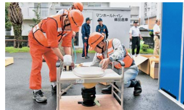
工具を使わず組み立てられるマンホールトイレ
