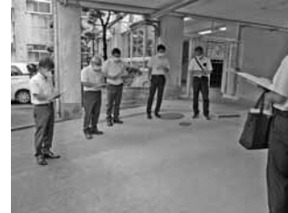
東間小学校 多目的トイレバリアフリー改修工事現地視察
