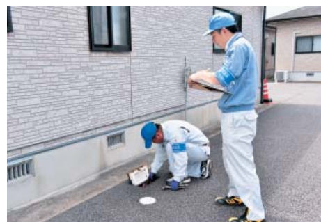
水道週間に実施する漏水調査
