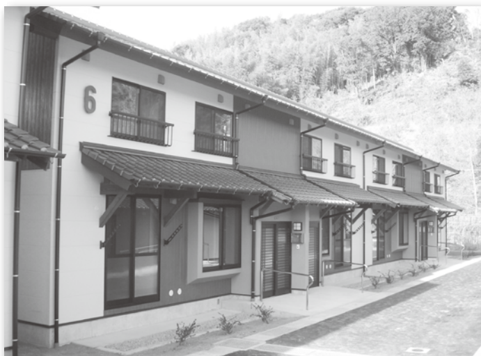
■市営住宅（東間団地）
