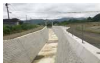
▲御溝川二次放水路の整備状況
