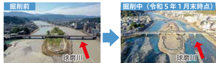
▲中川原公園の掘削状況
