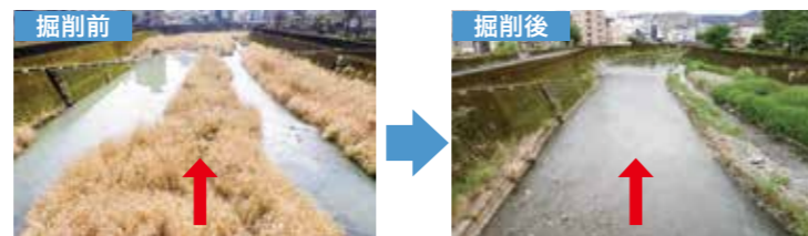
▲山田川の掘削状況
