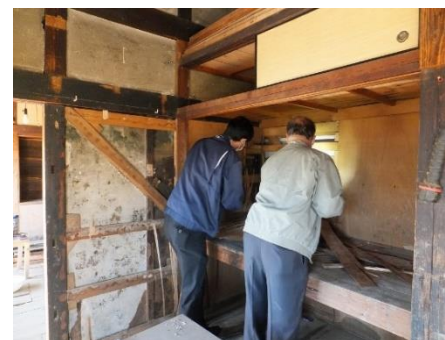
専門家等による現地調査の様子
