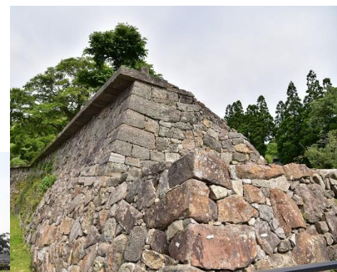
国指定史跡 人吉城跡 (復旧完了箇所)
