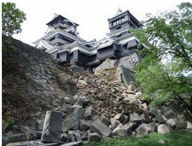
図 平成 28 年熊本地震による被害 熊本城、大天主と小天主石門が崩壊
