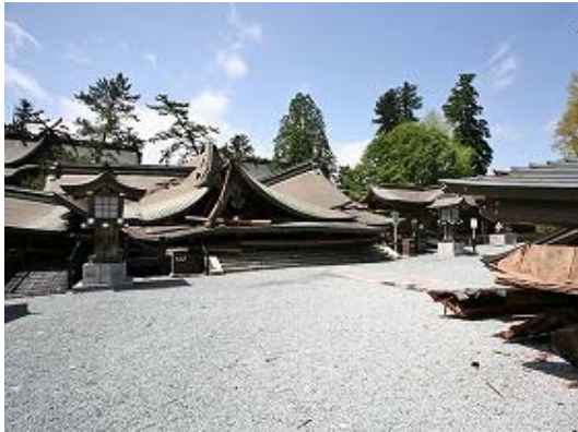
図 阿蘇市 阿蘇神社拝殿の倒壊(震度6弱)
