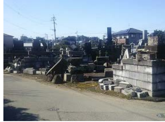
図 御船町 墓石の倒壊(震度6弱)
