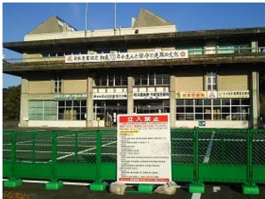
図 人吉市 使用不可になった庁舎(震度 5 弱)
