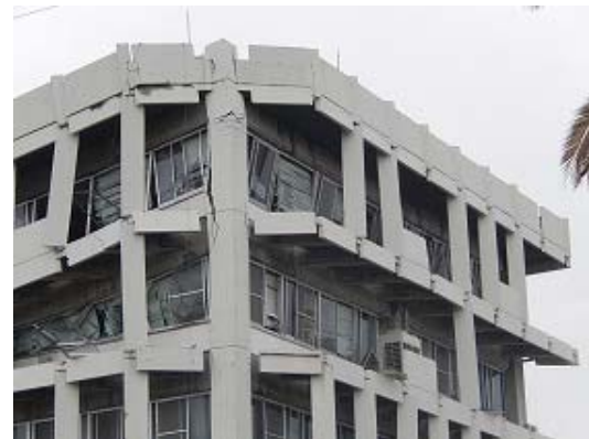
図 宇土市 庁舎局部破壊（震度 6 強）
