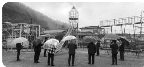
撤去される複合遊具（東間小学校）
