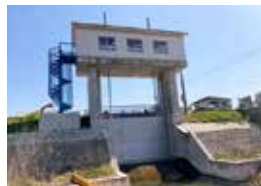
①御溝川の放流施設完成 （令和6年3月）
