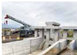
②御溝川の分流施設施工 状況（令和6年5月）
