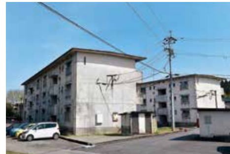
改修工事を予定している蟹作団地
