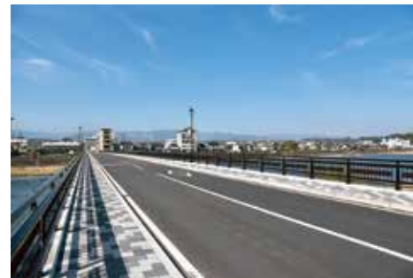
補修工事が完了した水ノ手橋
