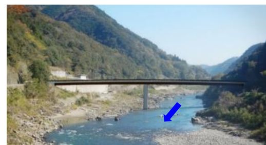
松本橋【鋼2径間連続鋼床版箱桁橋】
