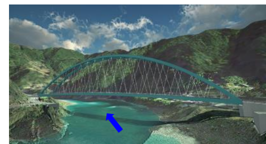
鎌瀬橋【鋼単純アーチ橋】
