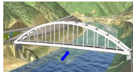
神瀬橋【鋼単純アーチ橋】
