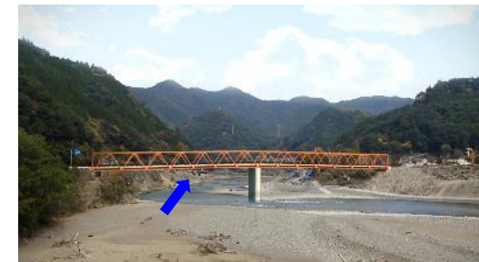
坂本橋【鋼2径間連続トラス橋】
