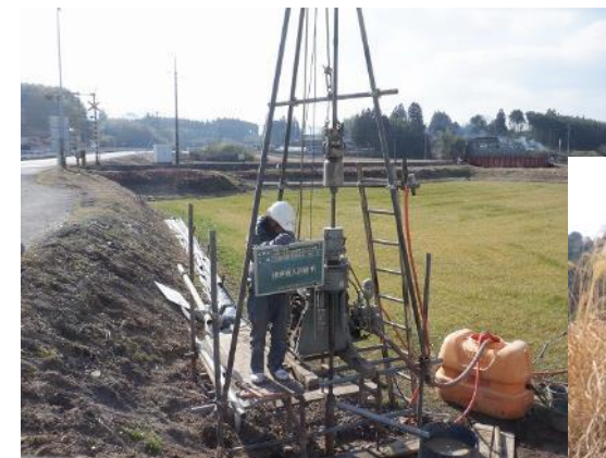
地質調査の状況 (錦町)
