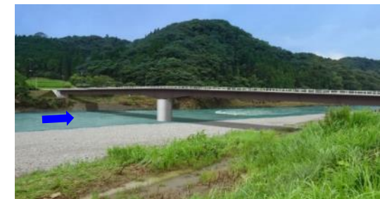
沖鶴橋【鋼2径間連続鋼床版箱桁橋】
