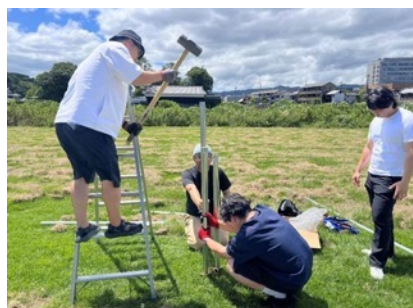
▲ 定点カメラの設置用ポールの設置の様子
