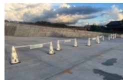
▲駐車場の区域を明示 ／コーン・バー設置
