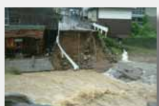
梅雨前線による豪雨で河川が氾濫した豪雨災害。美里町では道路寸断、土砂崩れで集落が孤立した。
