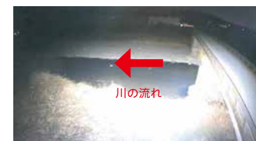
照明設備設置後
