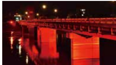
▲水の手橋の手すりなどに、変色可能なLED（発光ダイオード）照明を設置
