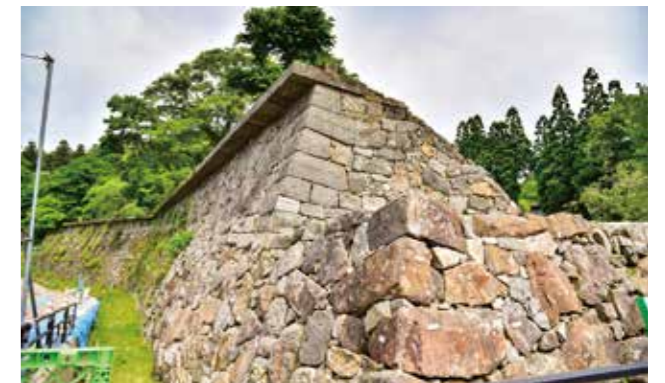
3月30日に修復が完了した武者返し
