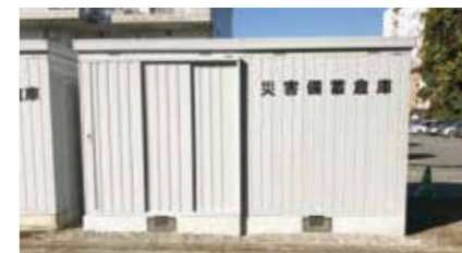
指定避難所に整備した災害備蓄倉庫
