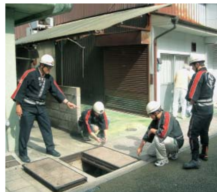
第1分団第2部 側溝点検の様子
