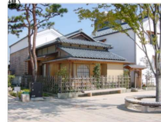
建物の連続性の創出 (曳家して作った茶室)
