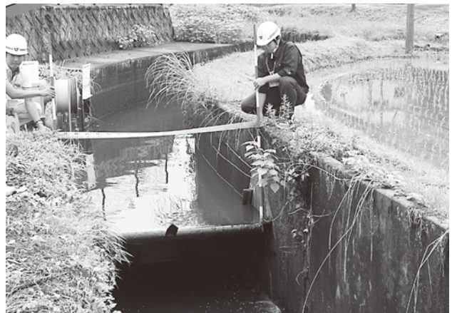
改修が行われる浪床地区水路のゲート
