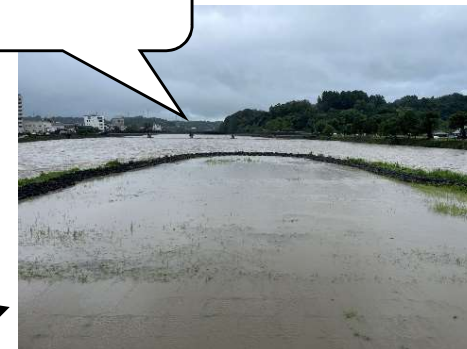
写真：公園浸水(R5. 7. 3 15時16分時点)
