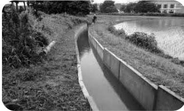
下城本地区水路改修工事
