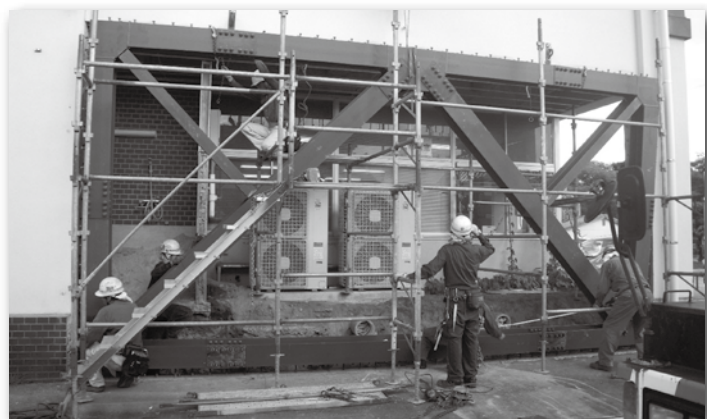
■小学校の耐震補強工事
