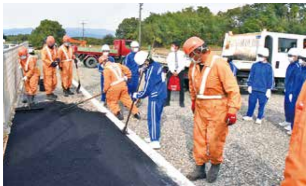
アスファルト合材を撒いた歩道をならす第三中生
